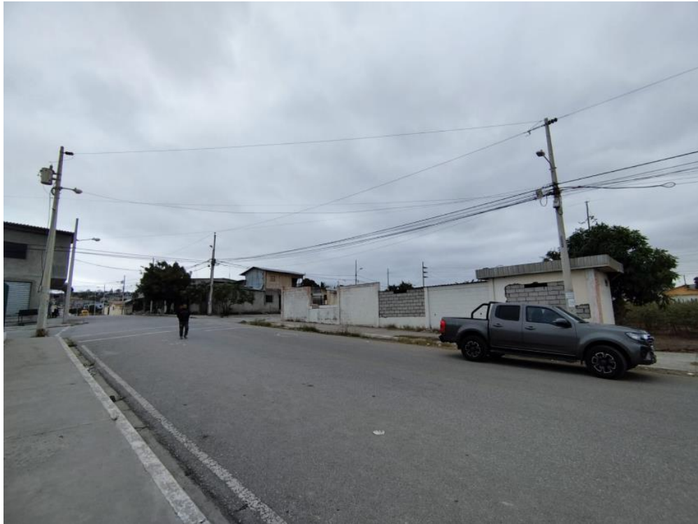
Fotografía 1. Vista frontal predio CCVP – Santa Elena
