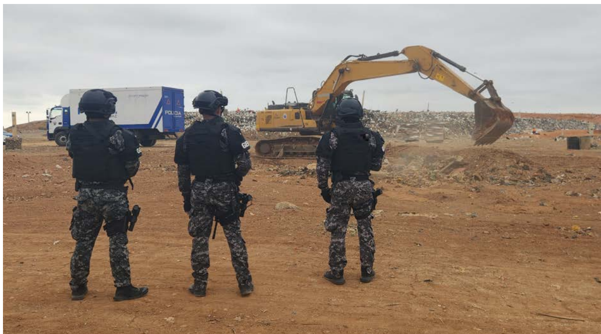
Imagen 17. Cobertura de la celda Fuente: STAND/UNODC
